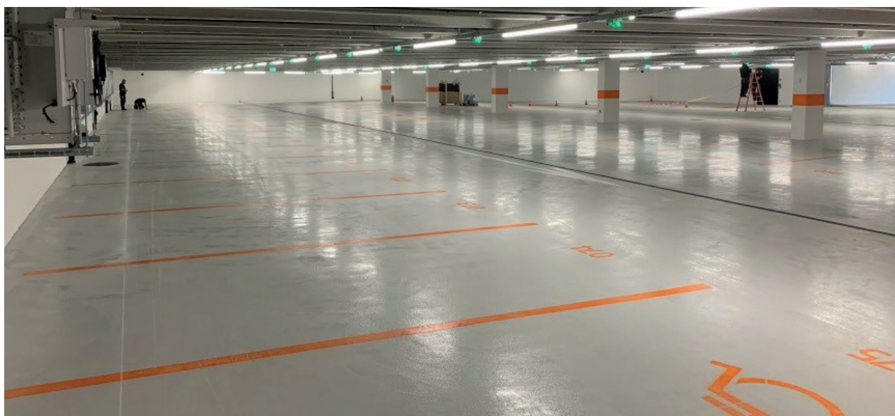
Figure 4 : Stationnement facile : Les dalles nervurées préfabriquées hautement précontraintes permettent des portées de plus de 17 m.
