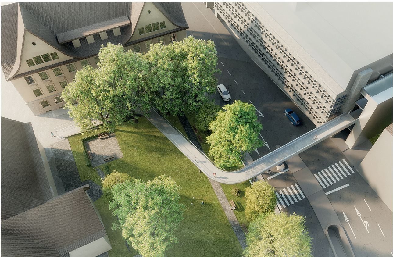
In elegantem Schwung vom Parkhaus in die Altstadt: Die „Brücke über den Graben“ verbindet in St. Gallen Altes und Neues. © Grischa Fischer, studiohometown
