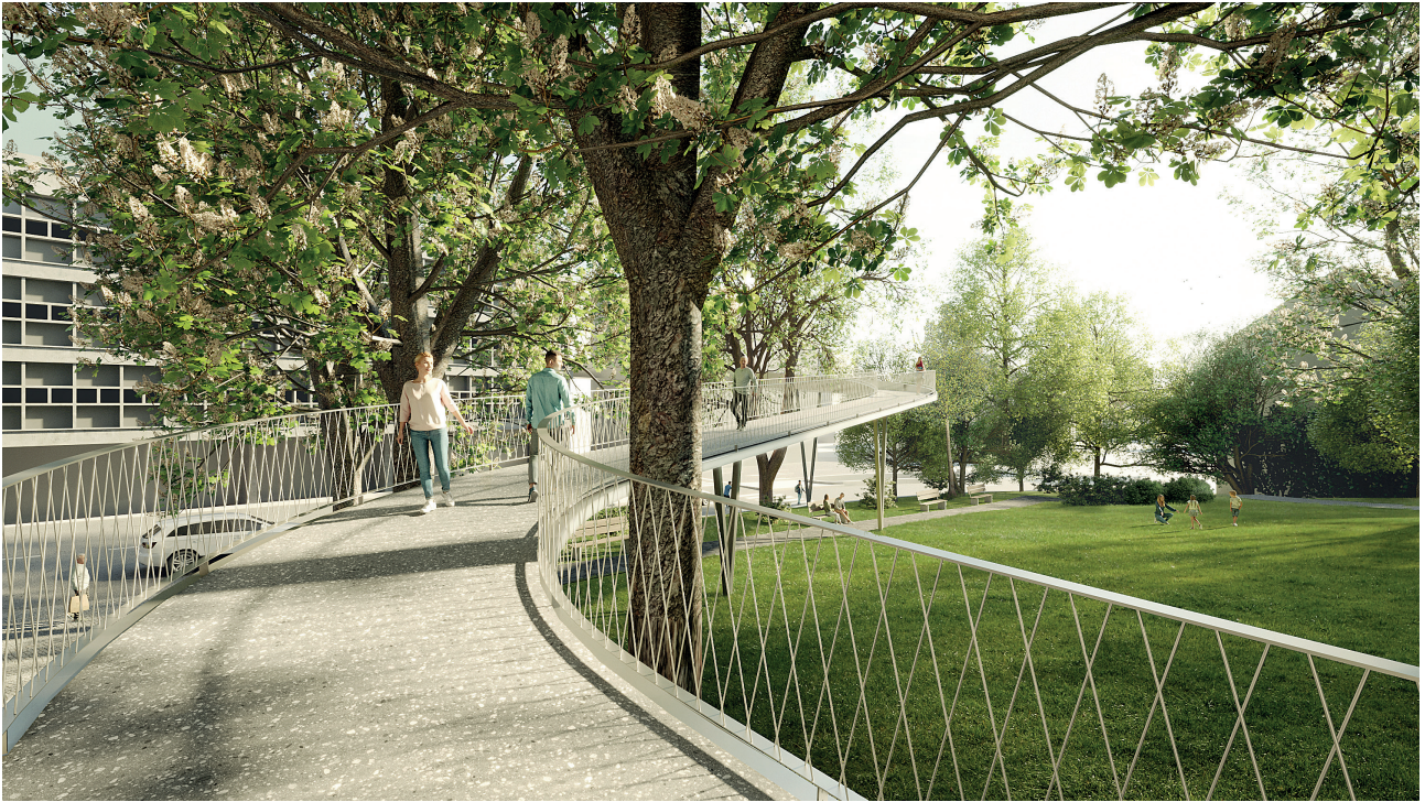
Die Möglichkeit, die Bäume mit einem 3D-Scanner zu erfassen und die Linienführung der Brücke mit dem Modell entsprechend auszulegen, schützt den alten Baumbestand. © Grischa Fischer, studiohometown
