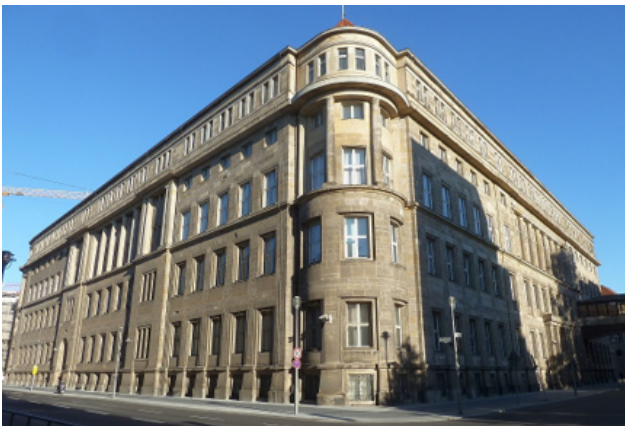
Auch beim Bauen im Bestand – hier die Sanierung des Gebäudes des Bundesamts für Gesundheit – und komplexen Situationen bringt SOFiSTiK Reinforcement die erwartete Leistung.
