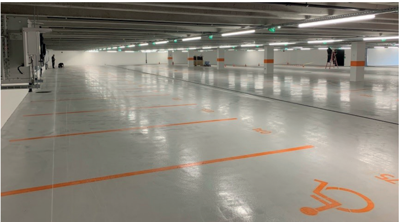
Bild 4: Einparken leicht gemacht: Hoch vorgespannte, vorfabrizierte Rippenplatten ermöglichen Spannweiten der Decke von über 17 m.
