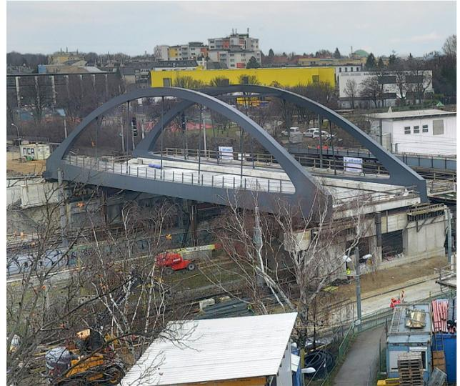
Fertiges Tragwerk nach dem Einschieben
